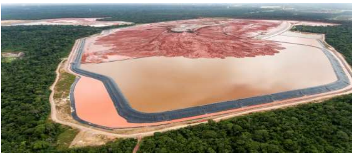
FIGURA 2 – VAZAMENTO DE SILICA DEBARRAGEM DE REJEITOS – BARCARENA (2018)
